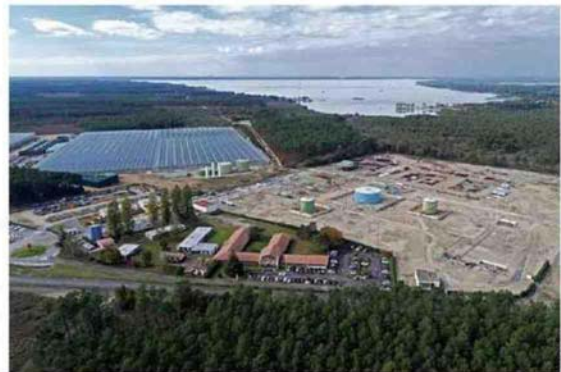
Parentis-en-Born (Landes). Depuis 2009, 15 ha de serres de Tom d'Aqui sont chauffées par l'eau chaude induite par le forage pétrolier de Vermilion, près de Biscarrosse.
